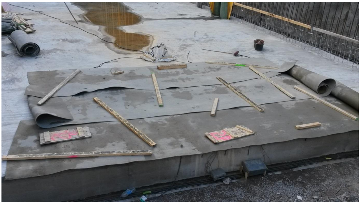
Figur 3-10 Värmemattorna täckta med betongtäckmattor.
