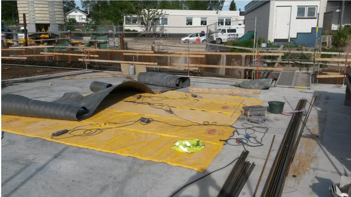
Figur 3-16 Värmemattorna vid utläggning innan de täcktes med isolering, försök 4.
