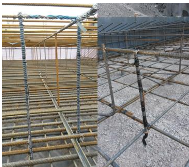
Figur 3-21 Temperaturgivare på glasfiberstag som knöts fast i över- och underkantsarmeringen.
