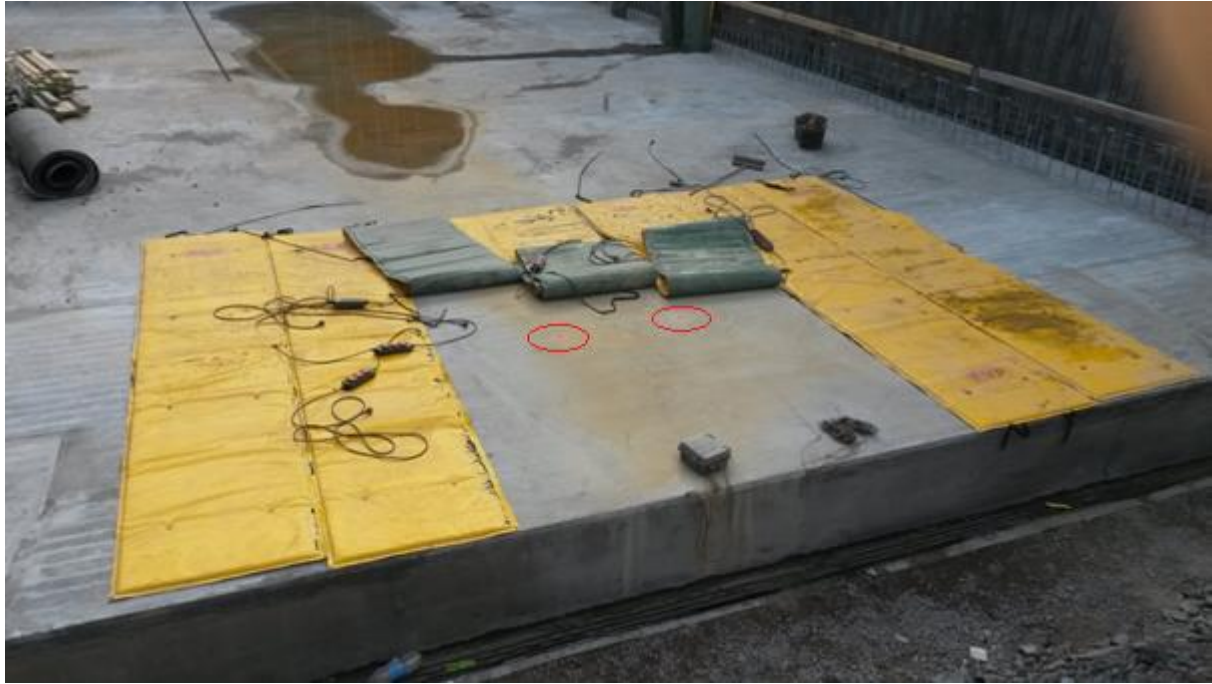
Figur 3-9 Värmemattorna innan de täcktes med isolering. Två sprayfärgade punkter kan urskiljas som markerar mätpunkternas horisontella läge.
