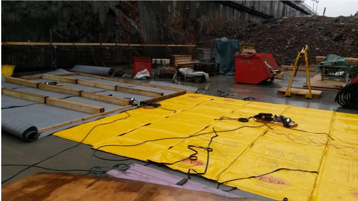
Figur 3-5 Mattor (gula) och isolering (grå) utlagda på bottenplattan. De västra mattorna täcktes med 10 mm betongtäckmatta.
